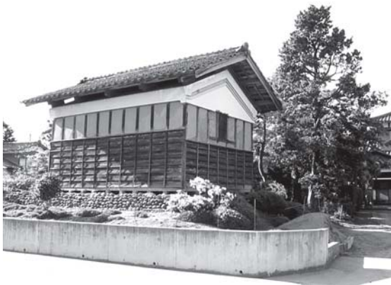
図7 土壁に間隔の狭い柱が露出した「信濃倉」 水倉番号 57 白根市保坂 2003年5月21日撮影 能登瓦を載せた置き屋根は越後平野の倉の典型。平屋造りのこの水倉は、道路から1.8m、母屋からも1.8mの高さで盛り土と石積みがされており、コンクリート擁壁の土留めを備えている。
